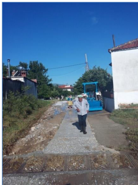
Εικόνα 23: Βλάβες Εσωτ. Οδοποιίας
